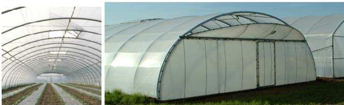
Figura 3.4 – Cobertura tipo “estufa”
